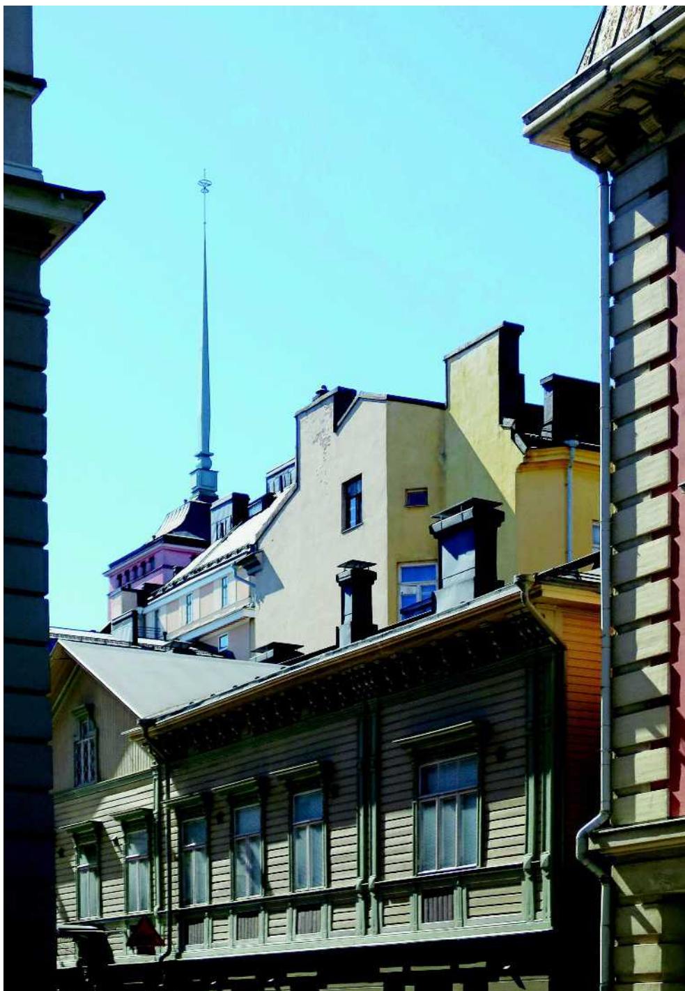
Painovoimaisella ilmanvaihhdolla varustettuja rakennuksia Helsingin keskustassa.
